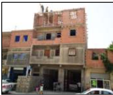
Figure3 : Le premier étage occupé, le deuxième en chantier et la quatrième dalle en cours d'exécution. Notons le propriétaire en train de faire monter le corps creux.
