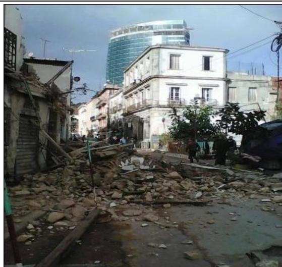
Fig.5: Effondrements d'un bâtiment dans la médina (24)
